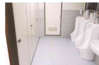
トイレ（改修後）
